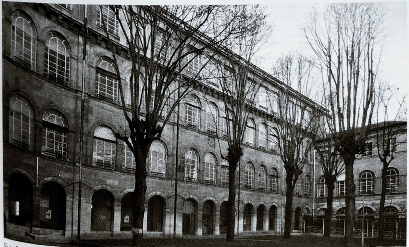
FIG. 5. – Cour de l'ancienne prison avant travaux. © Agence Bigoni-Mortemard.
