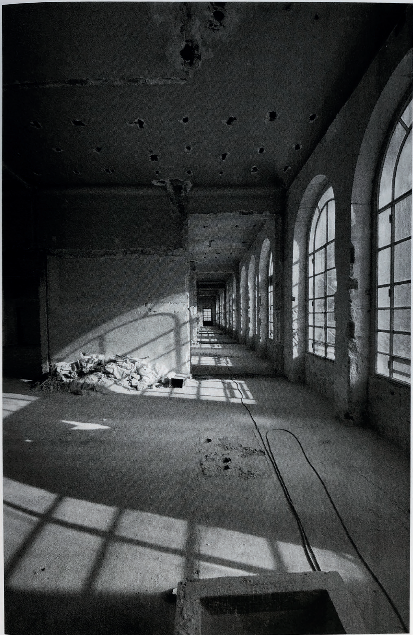
FIG. 8. – Vue intérieure avant travaux. © Agence Bigoni-Mortemard.
